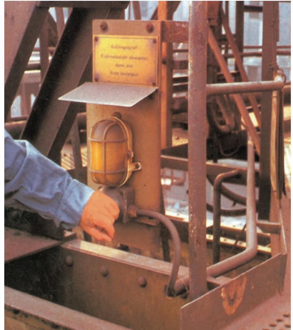
Bild 3-9: Der Ablöser gibt dem Kranführer Signal, dass er den Kran betreten will. Der Ablöser muss warten, bis durch Lichtzeichen Einverständnis gegeben wird
